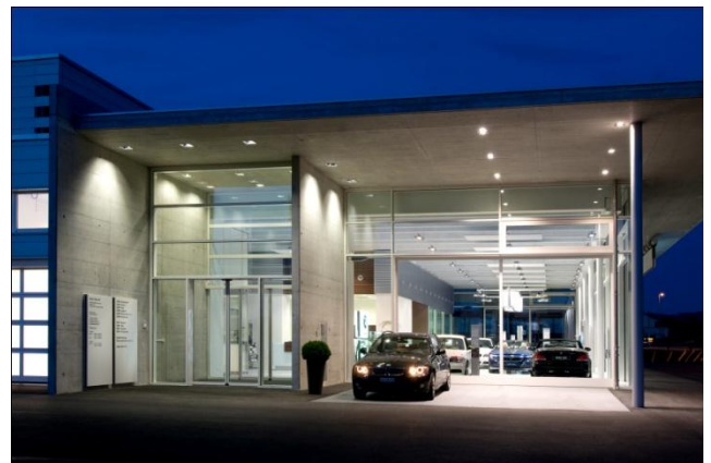
Neubau Garage Bickel Auto AG, Gachnang
