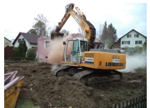
Abbruch des alten Wohnhauses (unten)
